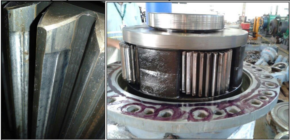
FIGURA 4 – Engrenagens do redutor da Mesa 1 com desgaste acentuado.
